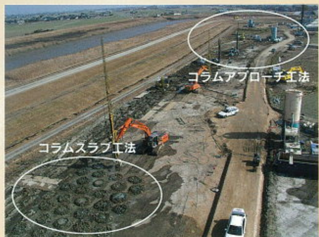
コラムアプローチ工法(写真奥)および コラムスラブ工法(写真手前)の施工状況
